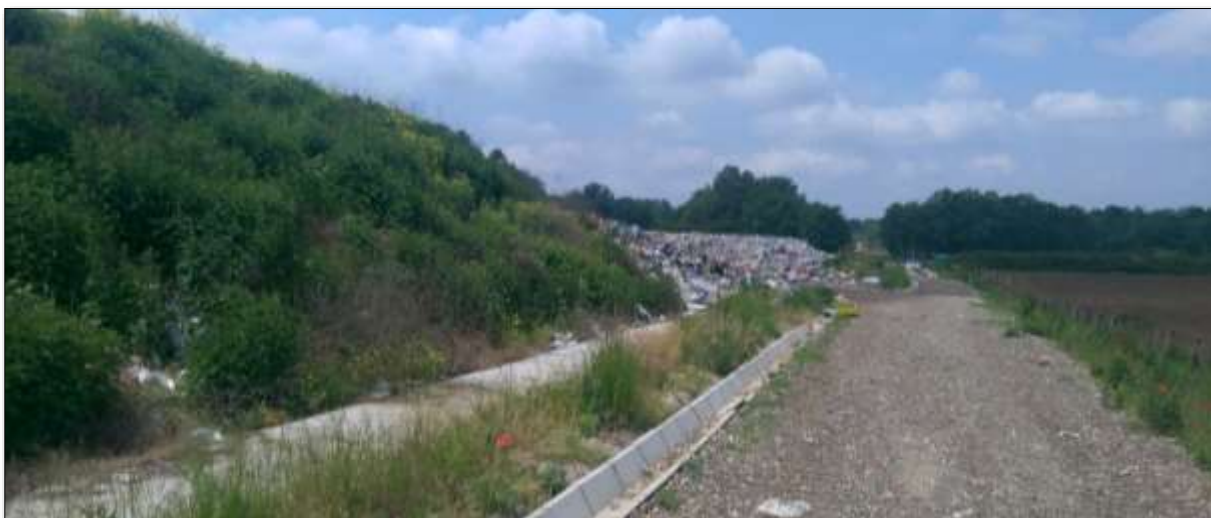
Slika 2.2.-5. Pogled na odlagališnu plohu s vidljivim obodnim kanalom i obodnom prometnicom
