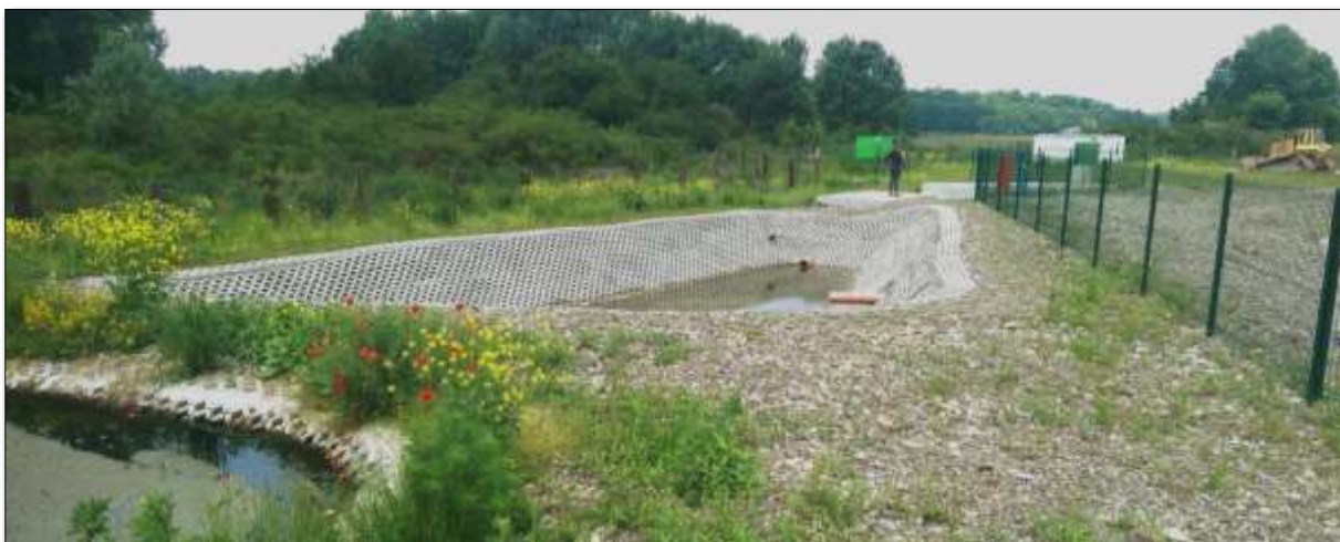
Slika 2.2.-3. Pogled na izvedene bazene za procjednu i oborinsku vodu, južni dio odlagališta
