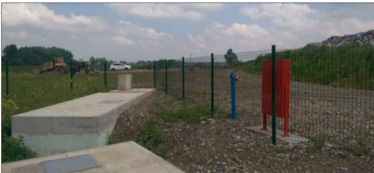
Slika 2.2.-5. Pogled na izvedenu crpnu stanicu za oborinske vode
